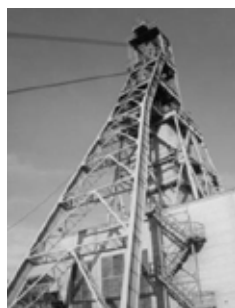
Рис. 2. Укосный шахтный рамный копёр пространственной рамно-связевой системы
